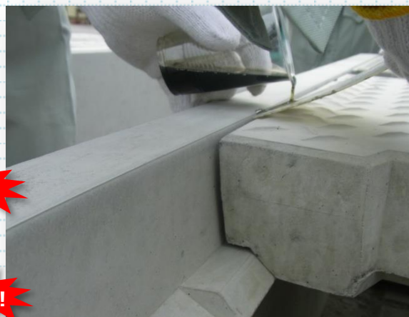
樹脂注入状況
